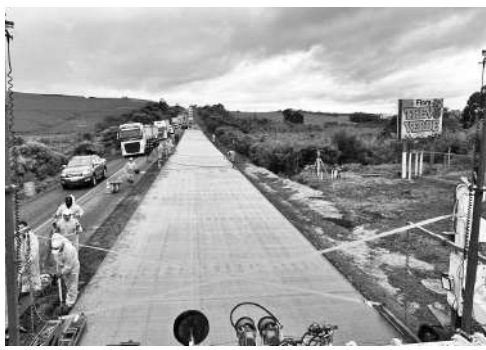
As obras na PR 280 seguem em bom ritmo.
